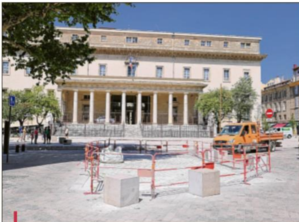
Les pavés ont été repris à certains endroits. Les finitions devraient être achevées fin juillet. / PHOTOS SDV
